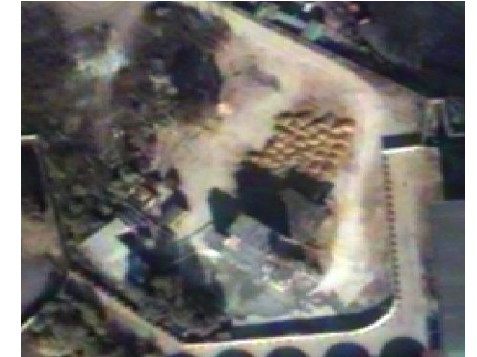
Скопления грунта, строительные материалы
